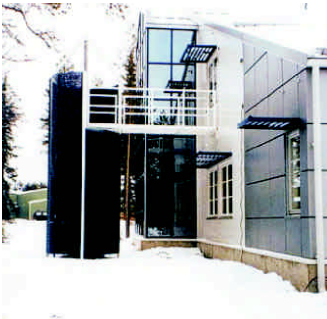
Bild 12. Solskyddsgallerovanfönstersamtfasadgaller typ USK-P monteratsom insynsskydd mot brandtrappa.
