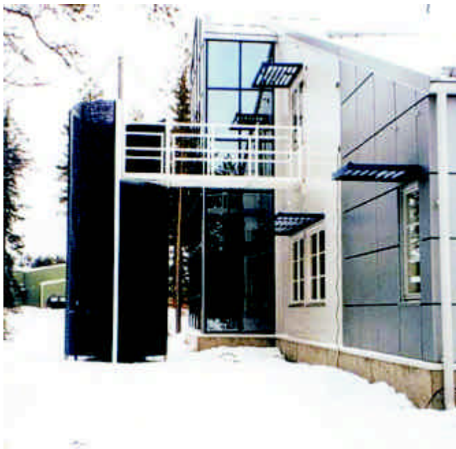
Bild 12. Solskyddsgallerovanfönstersamtfasadgaller typ USK-P monteratsom insynsskydd mot brandtrappa.
