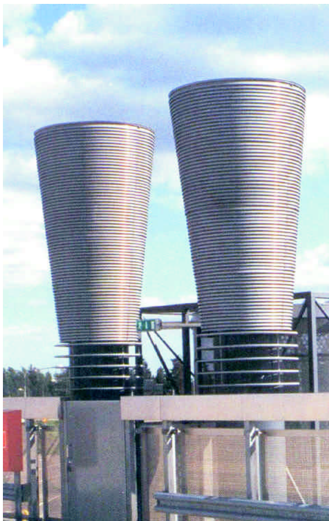
Bild1. KonisktformadegallertypUSK-PV. Gallrenibild är 3000mm höga ochharendiameterav1600mm. upptilloch800 mm.nedtil.
