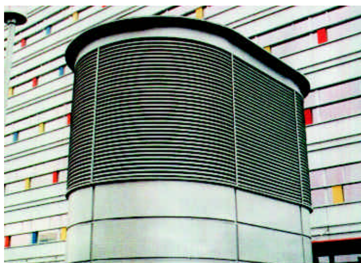
Bild3. YtterväggsgallertypUSP+USK-PV kombinerat som ventilationsintag.
