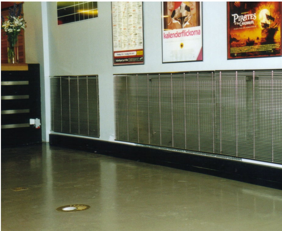
Bild 1. Ventilationsgaller typ PSP av mattborstat, rostfritt stål
