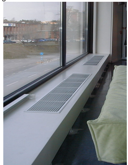
Bild 7. PSP-galler av aluminium, pulverbrännlackerad vit
