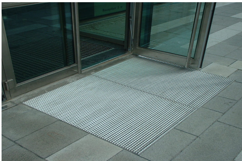
Bild 17. Skrapgaller typ JSP-L i rostfritt utförande med halkskydd.
